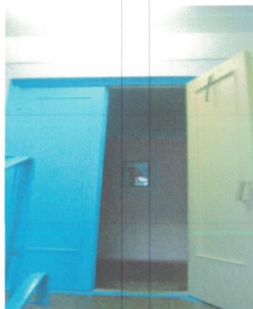
фото 16 дверь внутри здания
